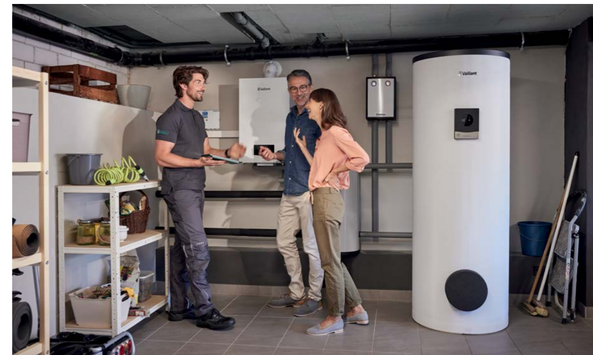
Hybridsystem aus Luft/Wasser-Wärmepumpe und Gas-Brennwertgerät
