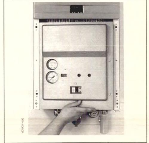
**Vorderwand** mit Unterkante über die Scharnierschraube der oberen Türhalterung einsetzen und mit den 4 Zapfen in die federnden Halterungen der Seitenwände einrasten.
